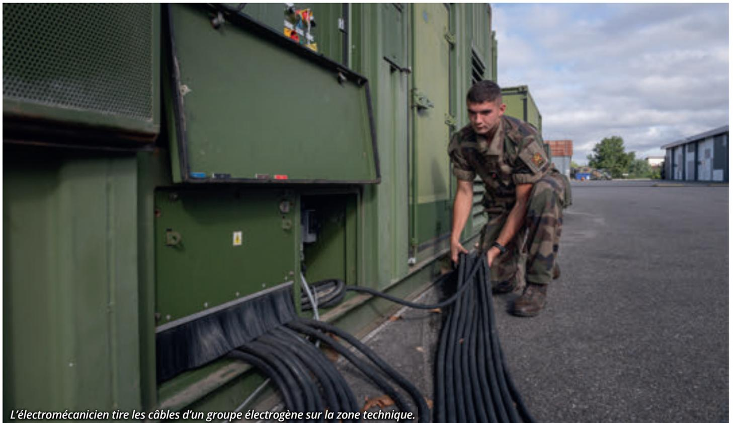
*L'électromécanicien tire les câbles d'un groupe électrogène sur la zone technique.*
